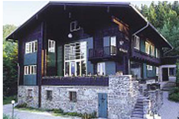
Alpenhof am Kreuzberg, Architekt Adolf Loos
