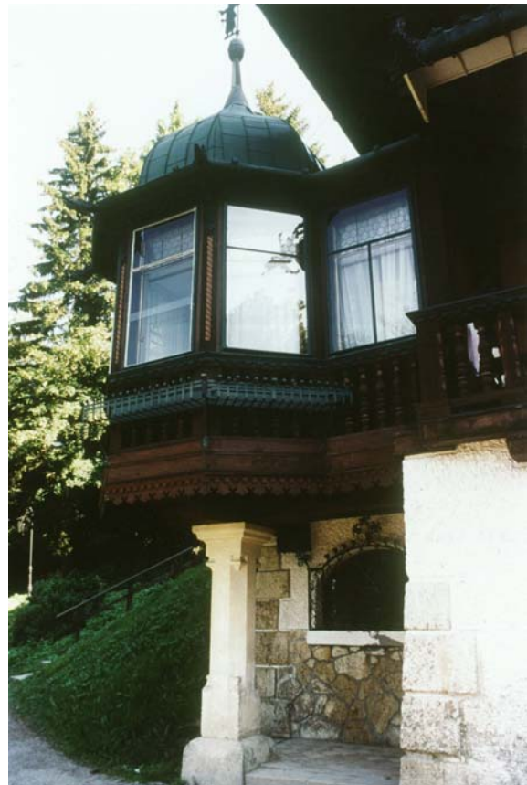
Semmering, Villa Schönthaler, Detail von einem Erkerfenster
